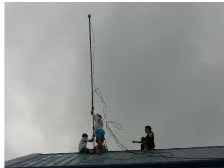
約 6m の鉄パイプを使用する様子
